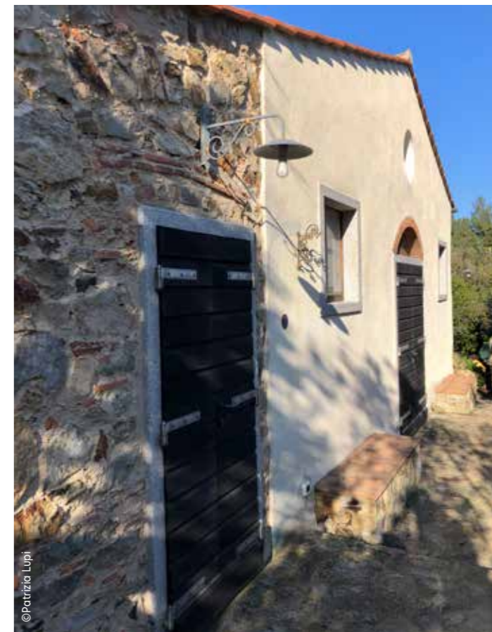
La casa "dei Catta" alla Cala - Marciana Marina
