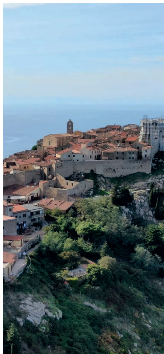
Vista del Castello da Poggio Chiusa Foto ©Michelangelo D'Elia
